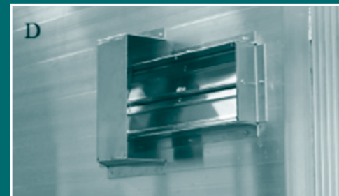
(D) air exhaust damper
